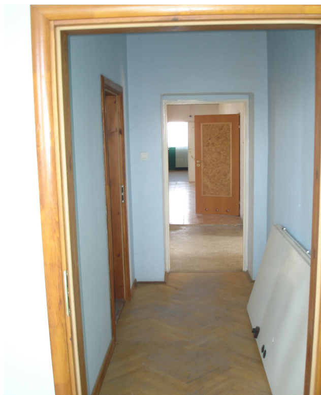
zdjęcie nr 3. Pomieszczenia drugiej kondygnacji
