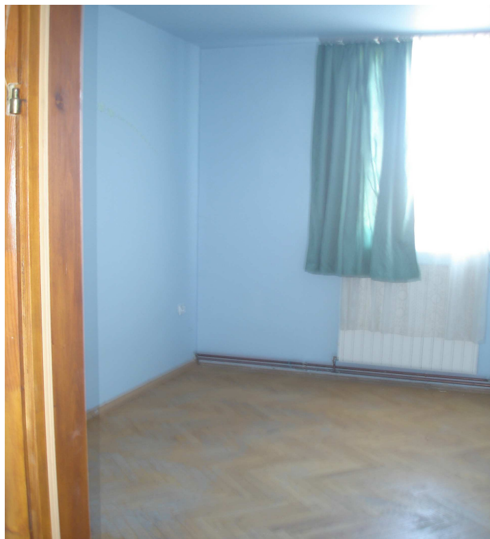
zdjęcie nr 4. Pomieszczenie drugiej kondygnacji
