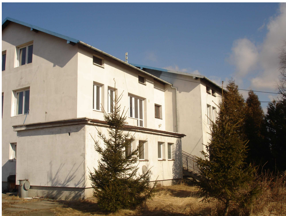
zdjęcie nr 1. Widok od strony bramy wjazdowej
