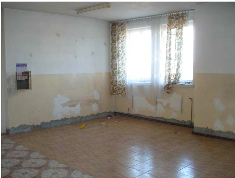
zdjęcie nr 7. Hall na pierwszej kondygnacji.
