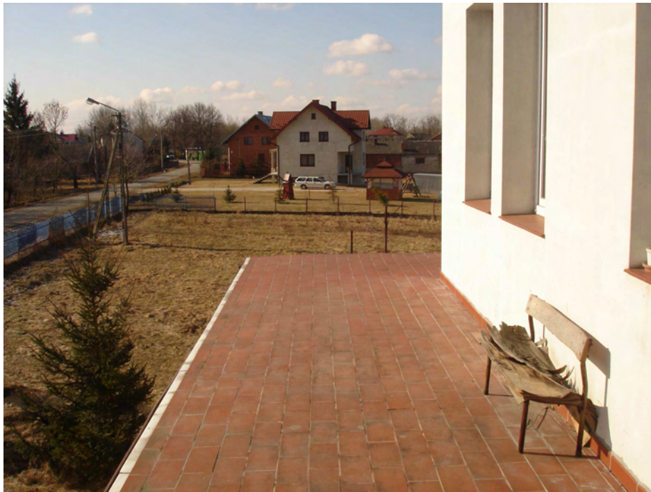
zdjęcie nr 6. Widok z pomieszczenia z przejściem na taras.
