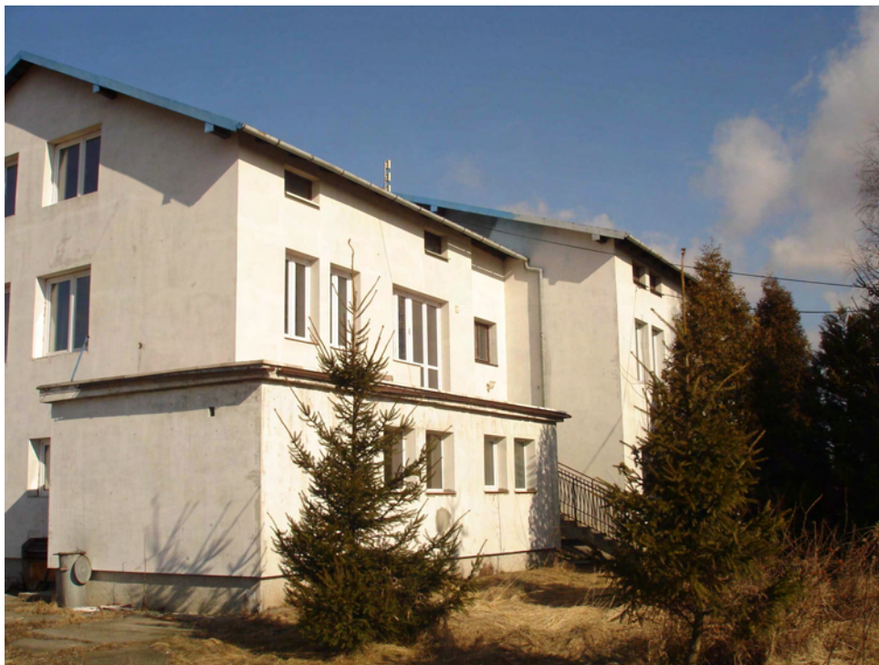
zdjęcie nr 1. Widok od strony bramy wjazdowej
